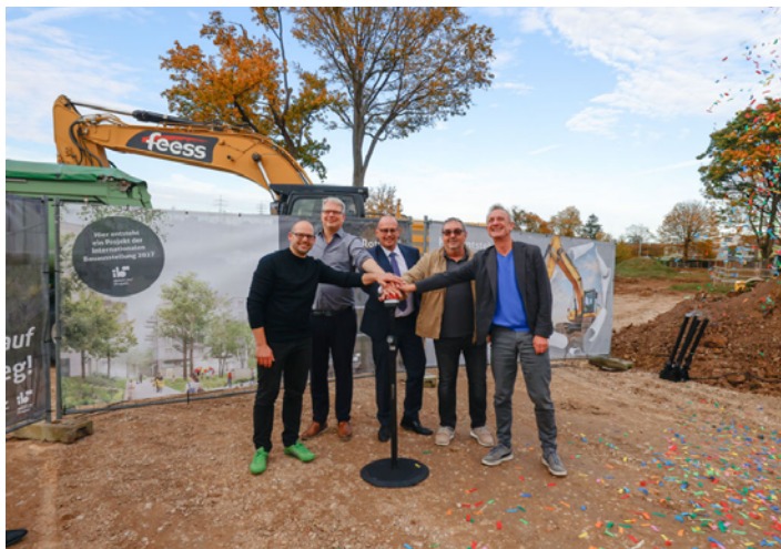
Buzzerschlag zum Baubeginn (Foto: Lena Lux)
