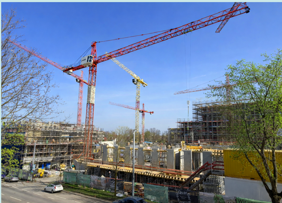
Ansicht Schozacher Straße – das Gebäude Jonathan entsteht
