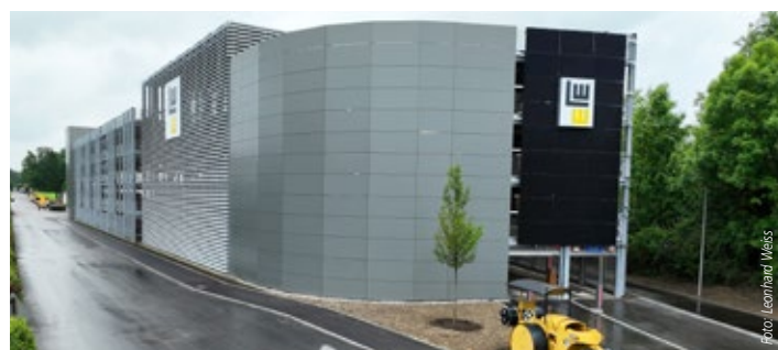
Das neue Parkhaus mit vielen PV-Modulen
