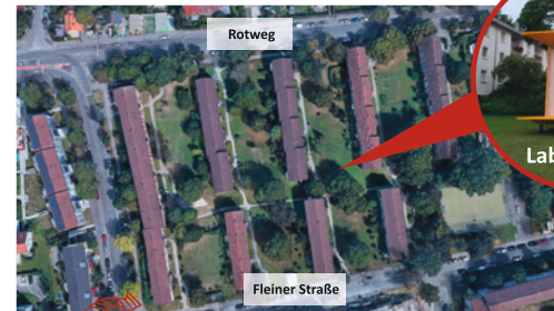
Von U-Bahn Schozacher Straße
